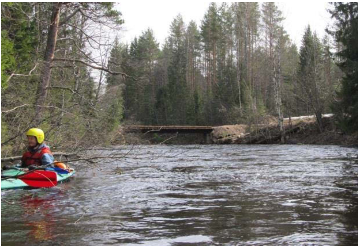
Фото 23 – Деревянный мост П15
