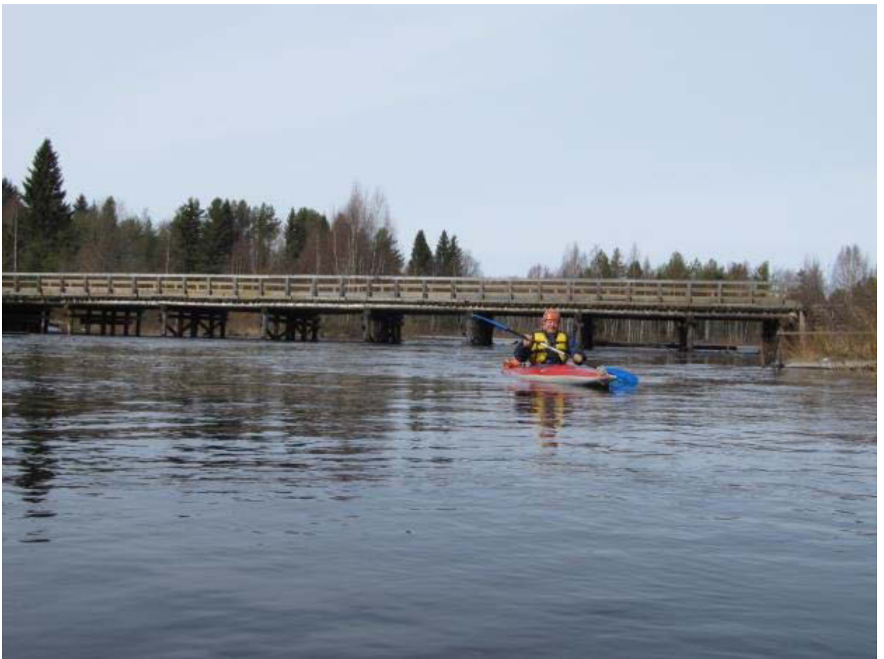
Фото 22 – Мост в д. Большие Горы
