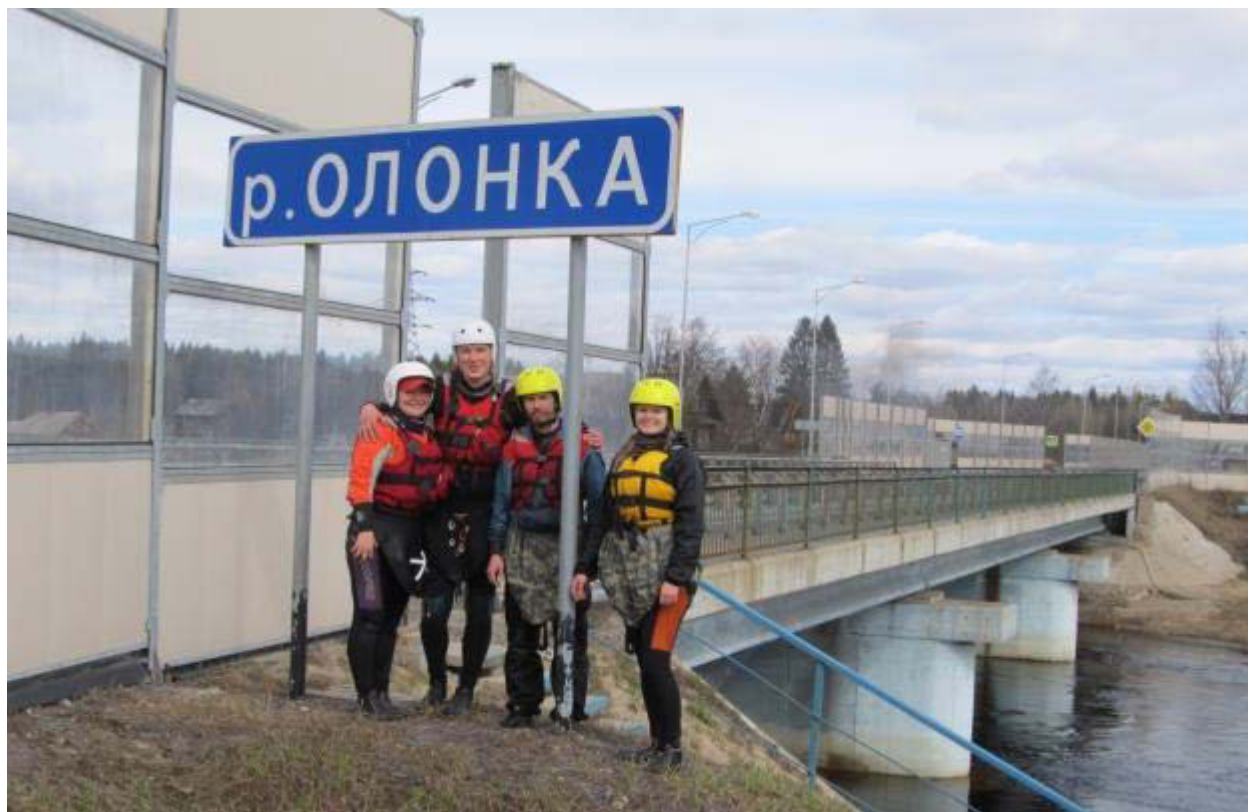
Фото 5 – Мост в деревне Торосозеро
