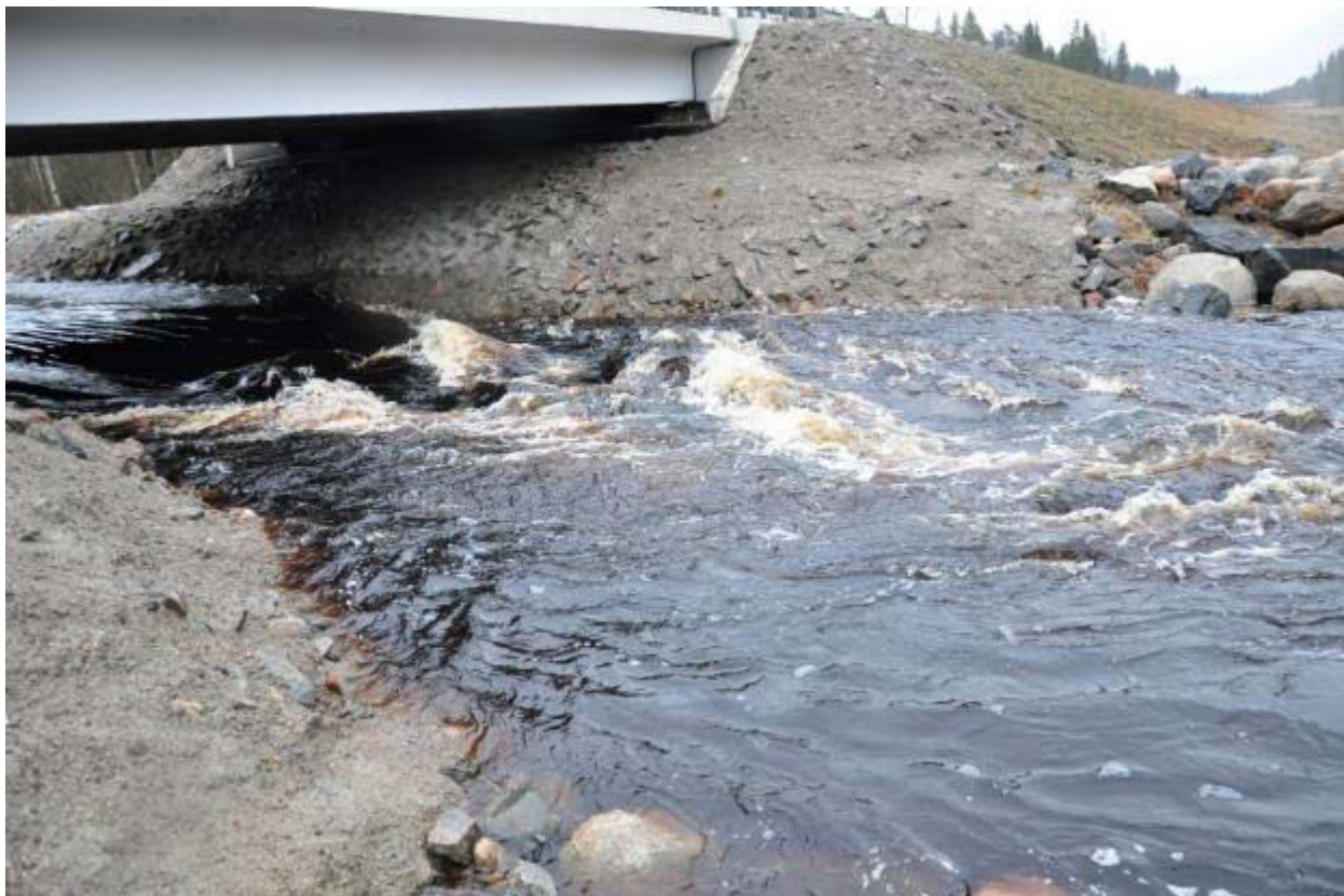
Фото 10 – Порог под мостом через реку Нялма.
