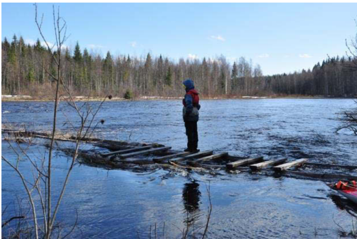
Фото 17 – Мост на зимнике
